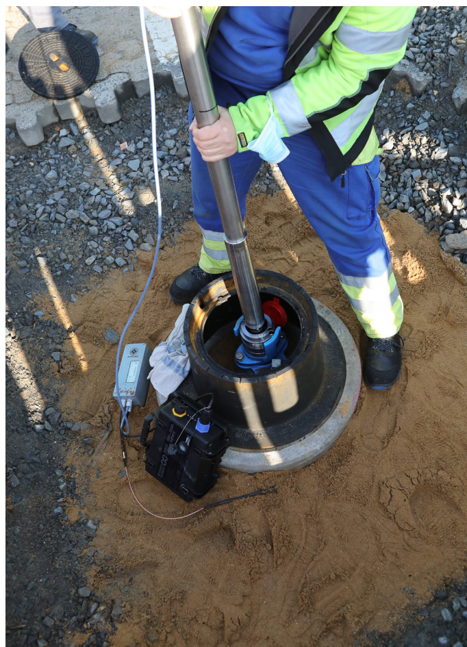
Montare de probă a compartimentului pentru senzori
