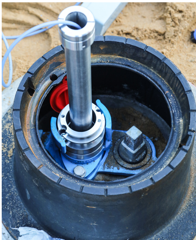
Montare de probă a compartimentului pentru senzori
